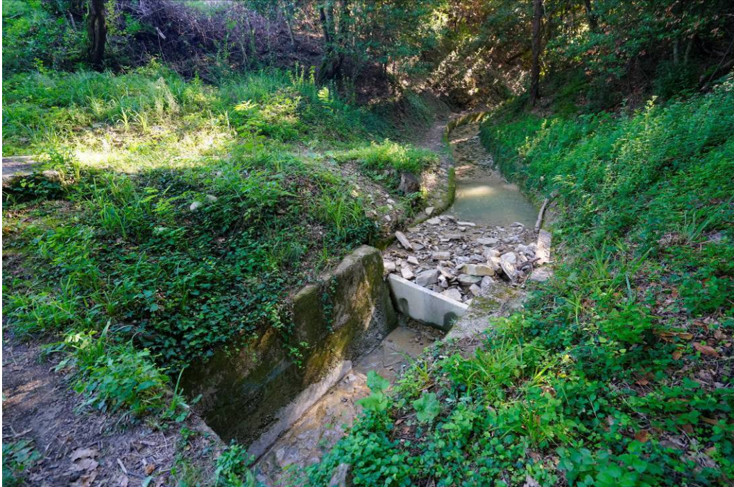
Slika 9: betonska bariera v profilu P16, ki deluje kot zadrževalnik plavin
