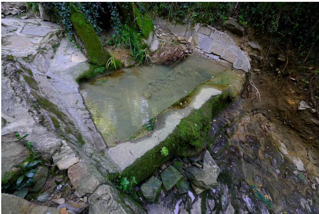
Slika 26: ustalitveni prag v profile P34/P35, iztok cevi ter tolmun pod njim
