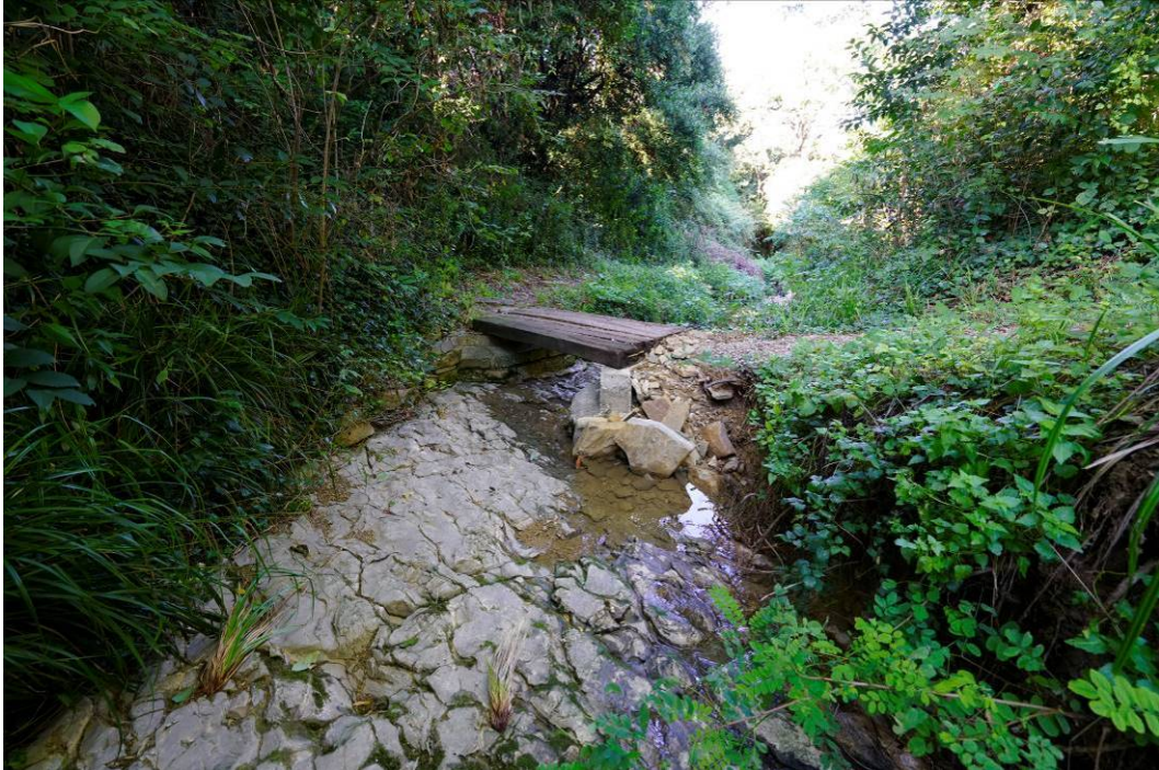
Slika 45: pogled gorvodno na most med profiloma P52 in P53 – očitno razgaljeno krilo desnega opornika
