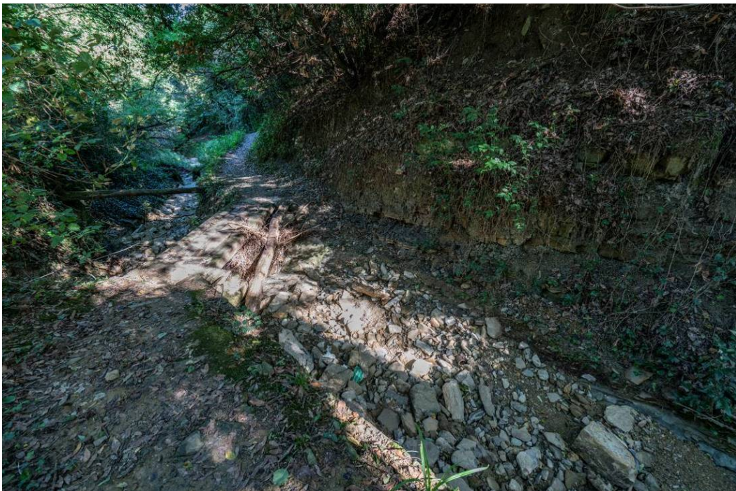
Slika 34: pogled dolvodno na zatrpano mostno odprtino v profilu P39 ter strmo flišno brežino na desni
