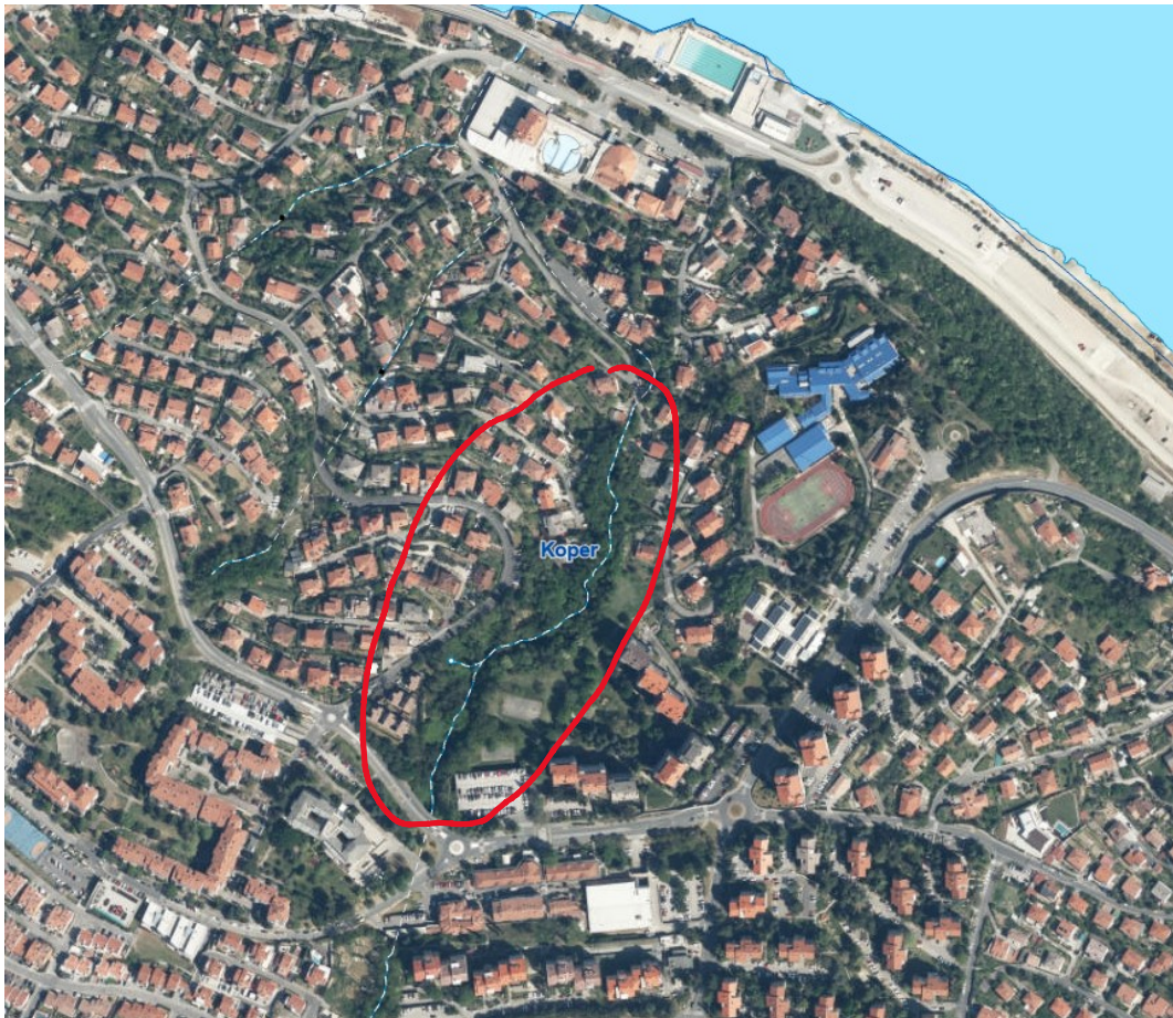
Slika 2: Obravnavan odsek grape v sredi stanovanjskih naselij Žusterna in Markovec
