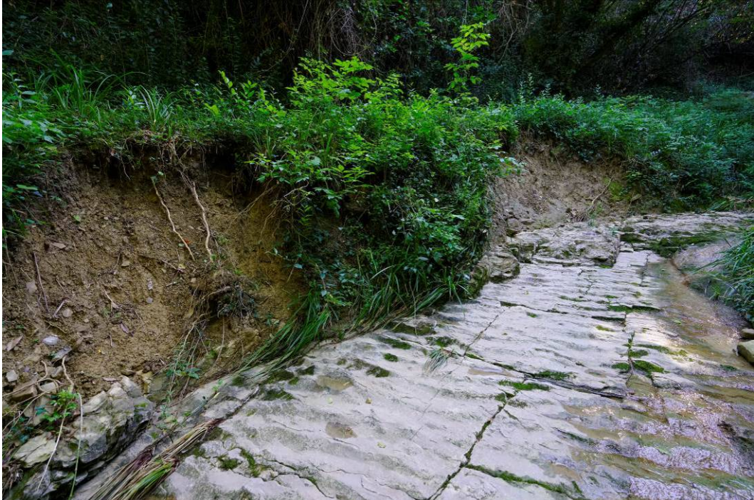
Slika 24: močno erodirana desna brežina med profiloma P32 in P33
