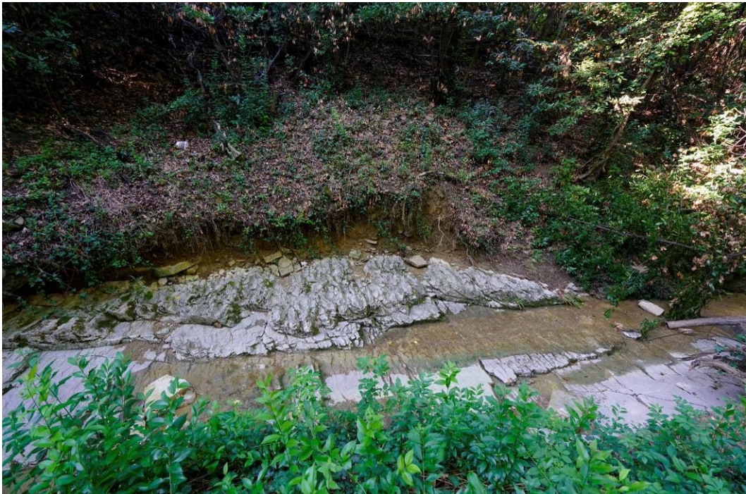
Slika 14: močno erodirana leva brežina pri profilu P22
