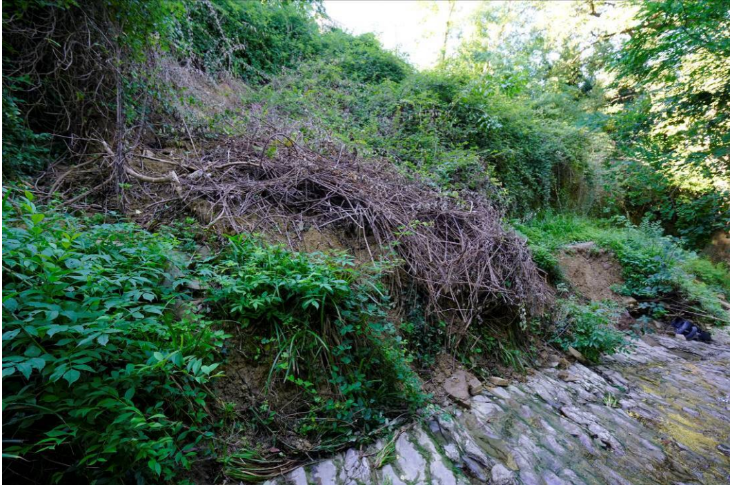
Slika 43: usad z levega pobočja pri profilu P48 je v celoti zasul pešpot
