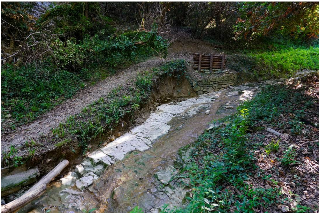
Slika 22: desnoobrežni zid z leseno podporo med profiloma P30 in P31, dolvodno je desna brežina močno erodirana, tako da je pešpot ogrožena oz. deloma spodkopana
