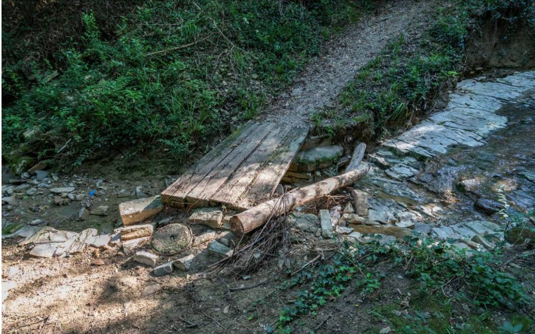
Slika 21: razgaljen levi opornik mostička med profiloma P27 in P28 ter erodirane brežine ob njem
