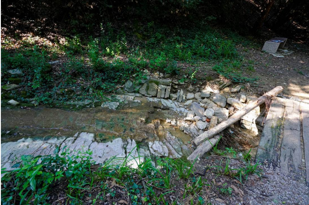
Slika 23: zajeda in podrto kamnito zavarovanje pri profilu P29
