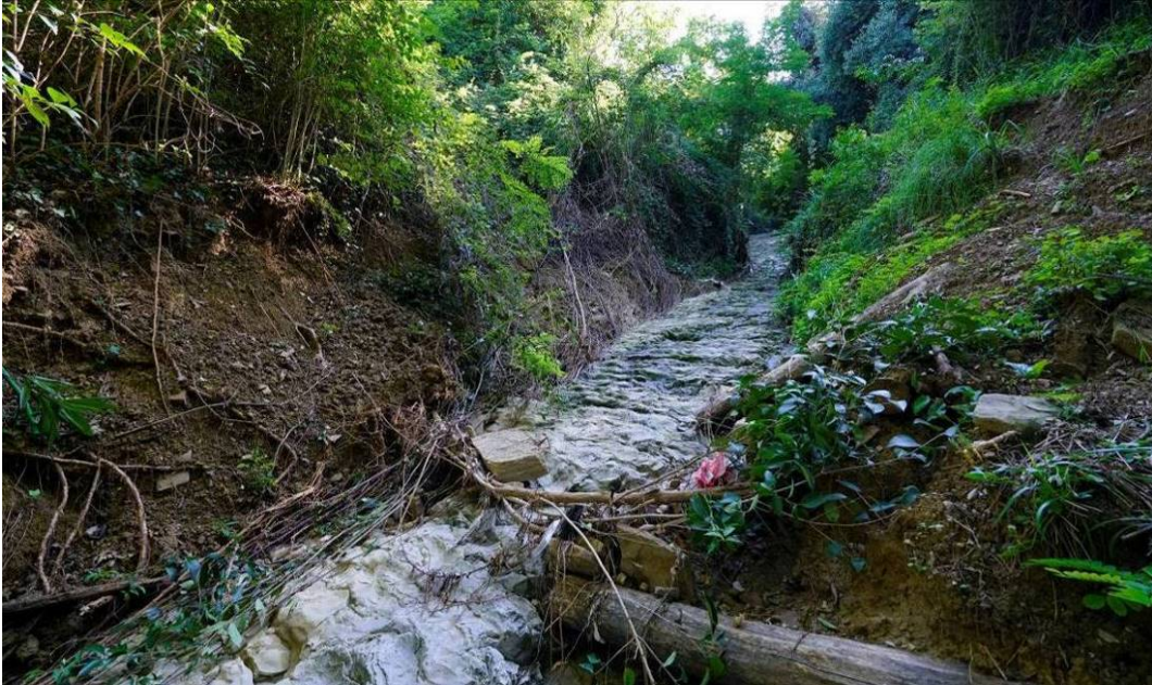
Slika 39: močno erodirane brežine gorvodno od profila P48
