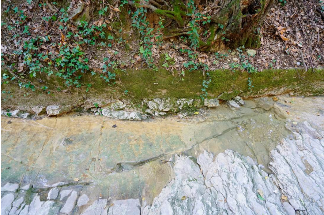
Slika 13: detajl struge pri profilu P19 – skalno dno ter delno spran stik betonskega zidu s skalo
