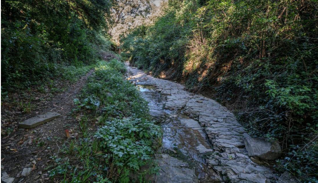
Slika 41: močno erodirana desna brežina dolvodno od profila P52
