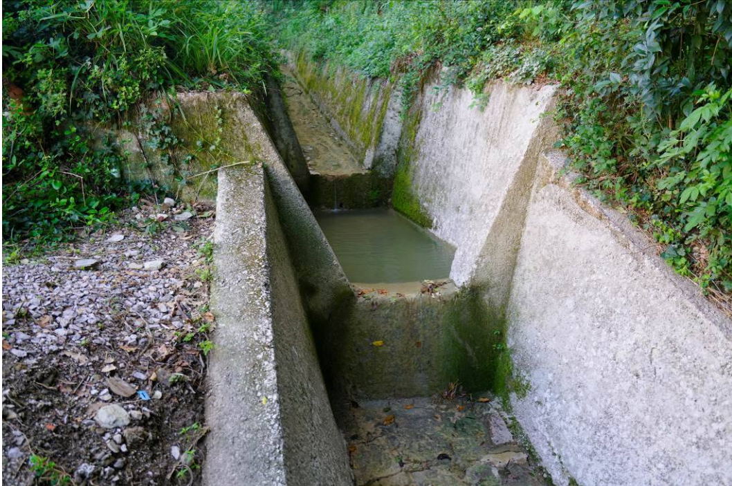
Slika 5: betonski peskolov med profiloma P2 in P5
