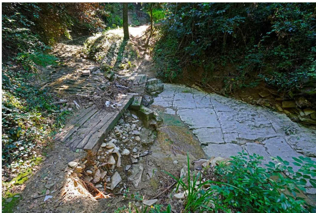
Slika 16: s plavinami zasut mostič pešpoti med profiloma P24 in P25, erodirana desna brežina in razgaljeno krilo desnega opornika
