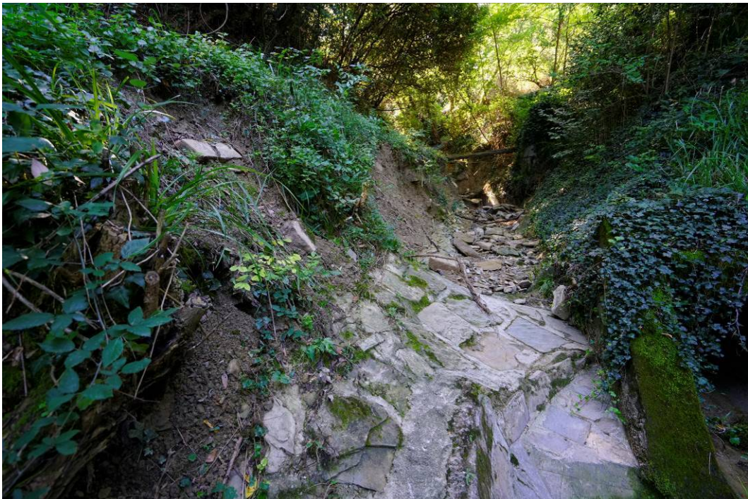
Slika 29: pogled na strugo gorvodno od praga v profilu P34/P35, močno erodirana desna brežina ter grobe plavine v strugi
