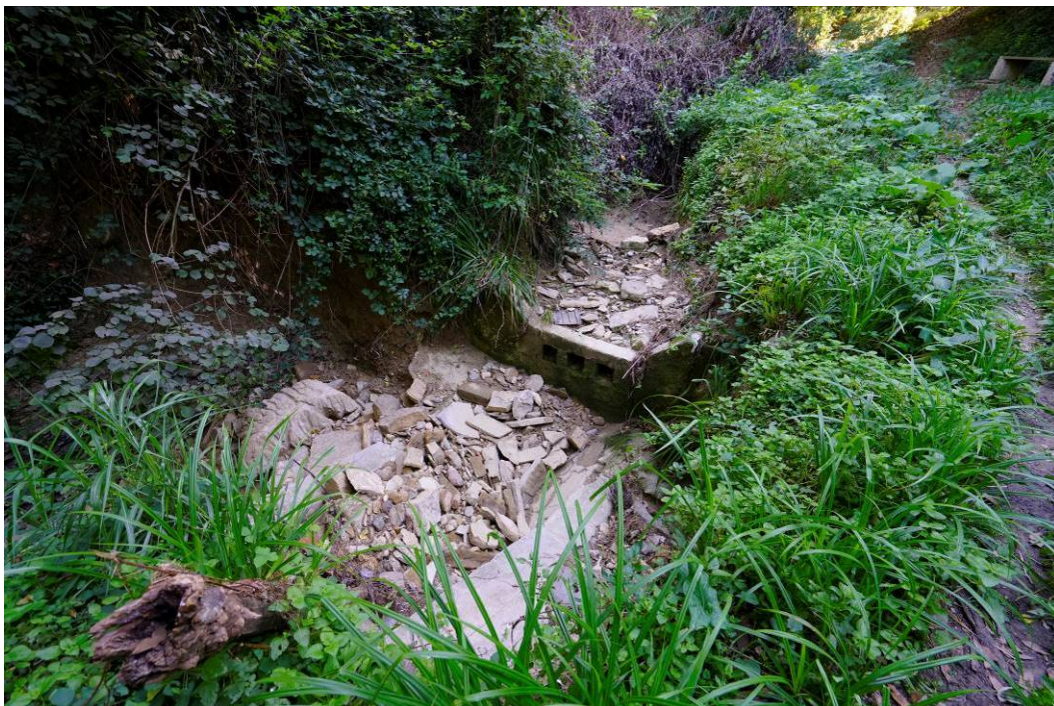
Slika 35: betonski ustaljitveni prag v profilu P43/P44
