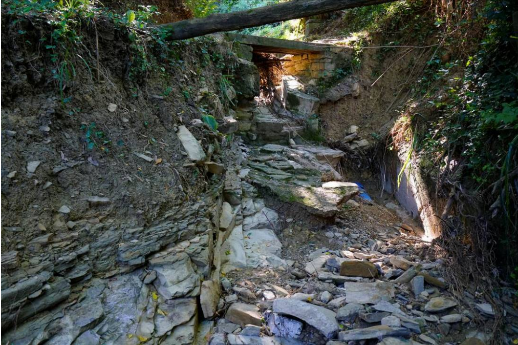
Slika 32: globinsko erodirana struga dolvodno od mostu med profiloma P38 in P39, razgaljeni mostni oporniki in spodkopan tlak na dnu struge
