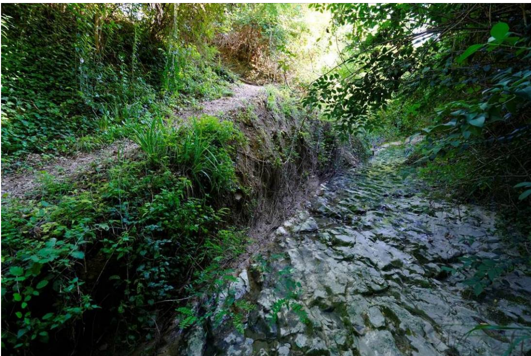
Slika 44: pogled gorvodno od profila P53 na močno erodirano desno brežino in spodkopano peš pot
